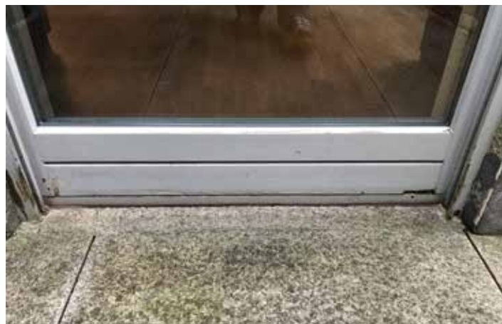
Sockel mit leichter Beschädigung rechts unten durch Feuchtigkeit und Ameisen. Foto: Björn Alexander Assmus
